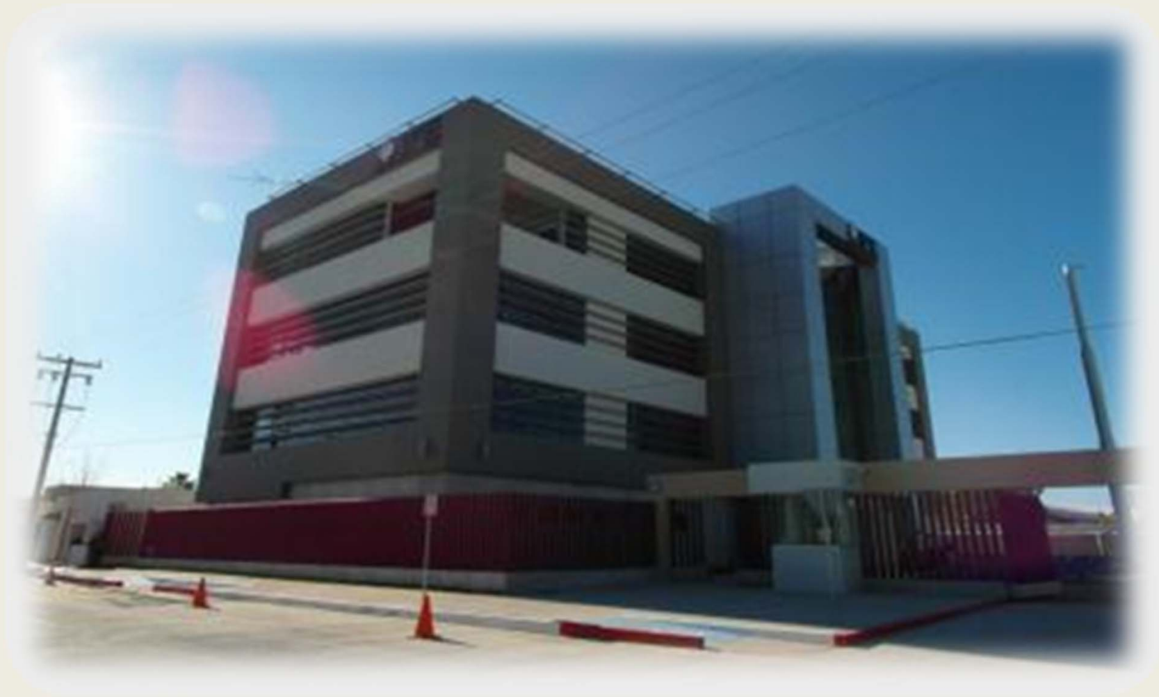
Vista exterior del edificio
