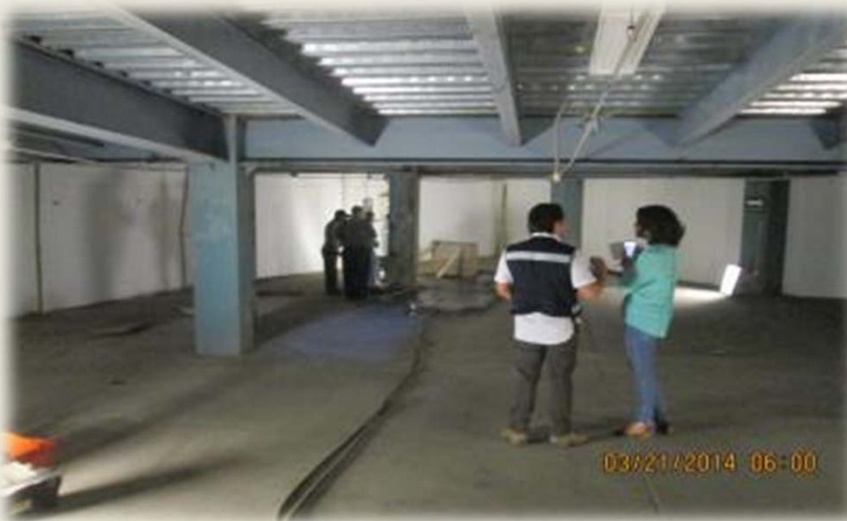
Pruebas de líquidos penetrantes en estructura.
