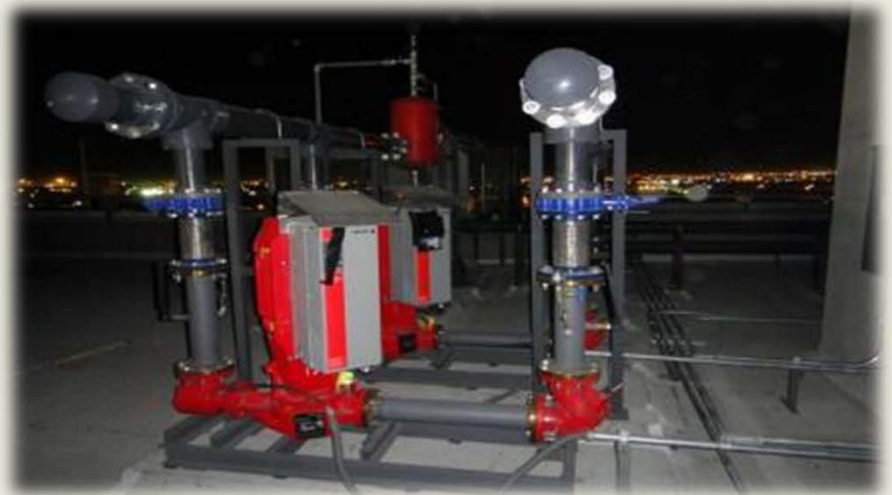
Bombas de Chiller
