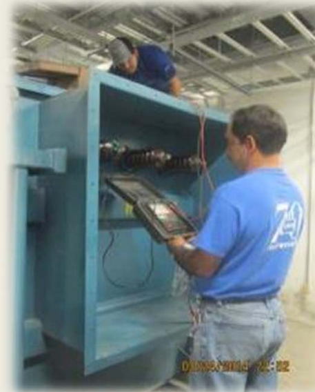
Revisión de transformador y tableros.
