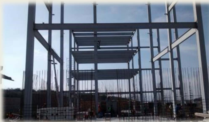
Armado de acero para muro de concreto
