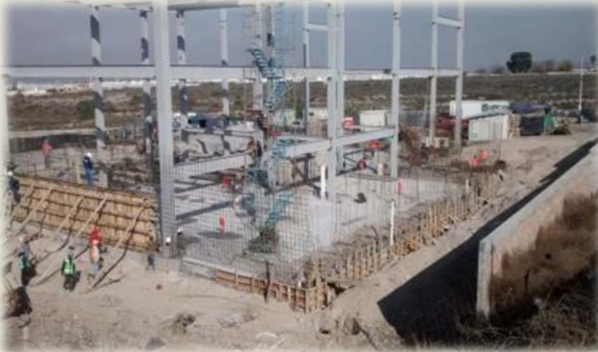
Habilitado de cimbra
