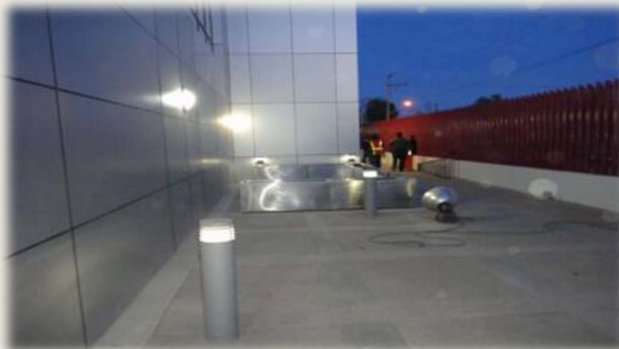
Maceteros en fachada principal
