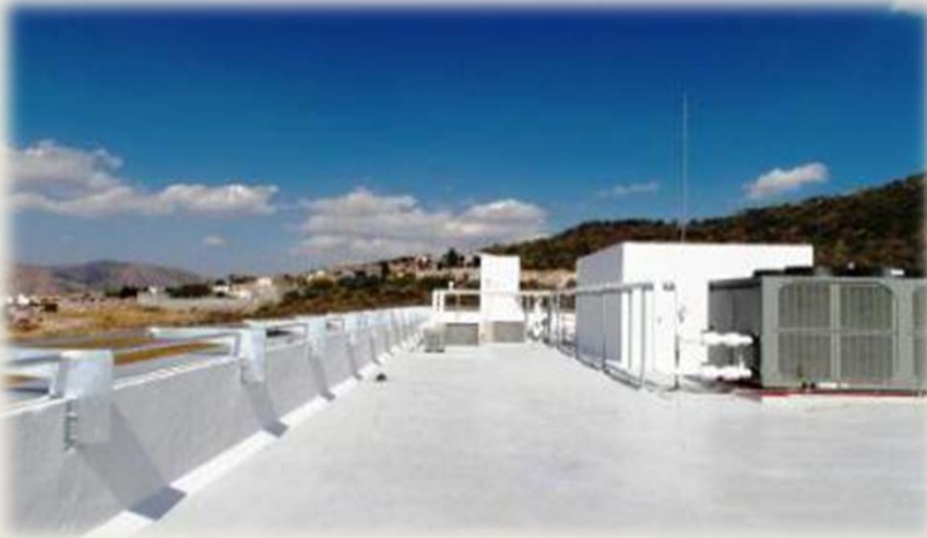
Azotea del edificio
