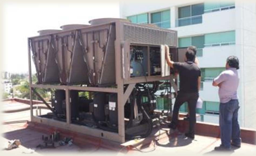
Revisión del Chiller
