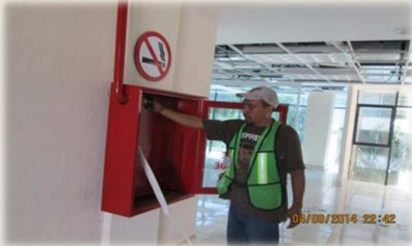
Pruebas del sistema contra incendio (hidrantes).
