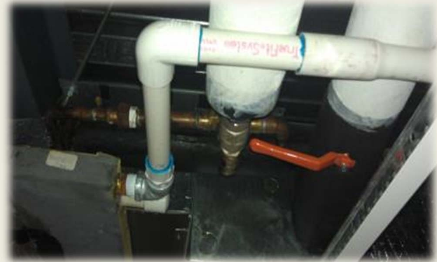
Revisión de equipos de aire acondicionado.
