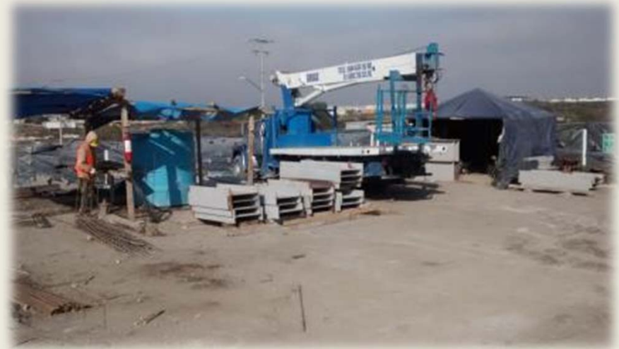
Habilitado de acero y estructura metálica
